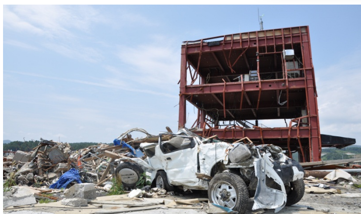
南三陸町・防災対策庁舎、ここで多くの職員が亡くなられた
